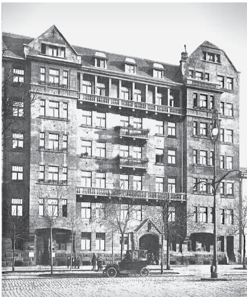
Ilustracja 1-10. Kamienica Piotra Drzewieckiego w Alejach Jerozolimskich, widok krótko po ukończeniu budowy. Źródło: Dom przy Al. Jerozolimskiej w Warszawie , „Przeгляд Techniczny”, 1912, nr 45, tabl. XV
