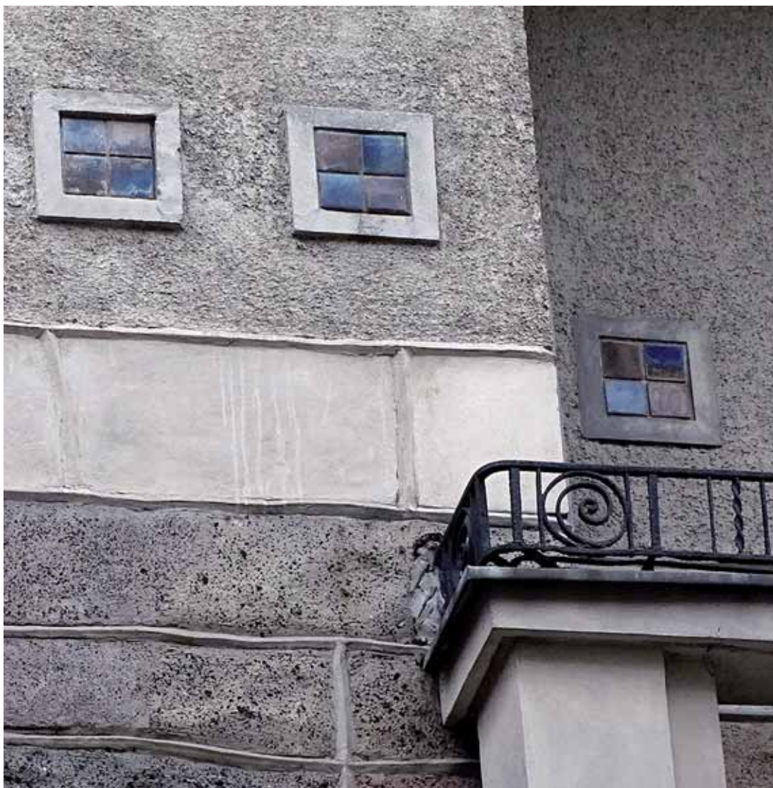
Ilustracja 1-39. Glazurowane płytki ceramiczne na elewacji frontowej kamienicy przy ulicy Lwowskiej 17, stan z 2018 roku. Fot. P. Kilanowski
