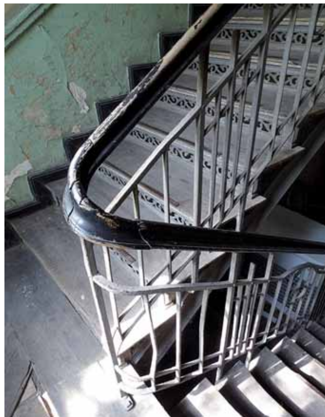
Ilustracja 1-23. Balustrada na głównej klatce schodowej w kamienicy przy Alejach Jerozolimskich 57, stan z 2017 roku. Fot. P. Kilanowski
