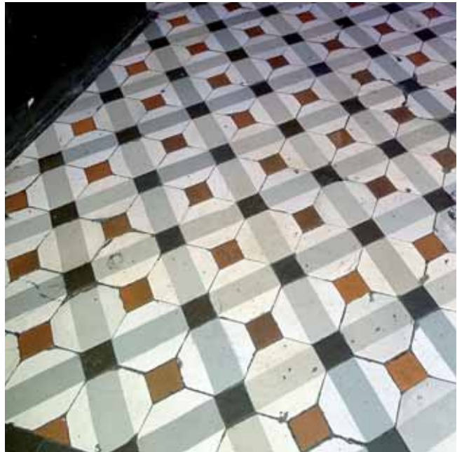
Ilustracja 1-20. Fragment posadzki ceramicznej w sieni wejściowej w kamienicy przy Alejach Jerozolimskich 57, stan z 2017 roku. Fot. P. Kilanowski
